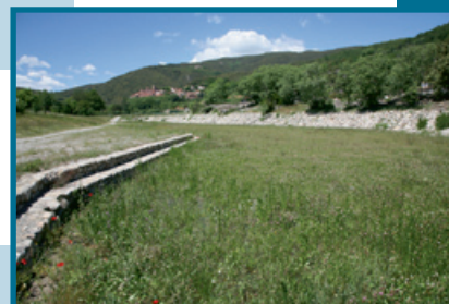
Bassin de rétention, Can Malcion
