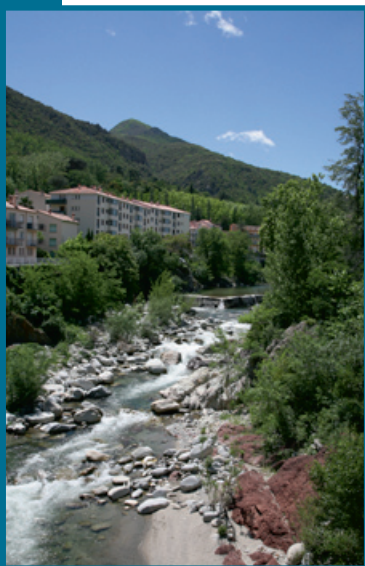
Le Tech en aval du seuil
