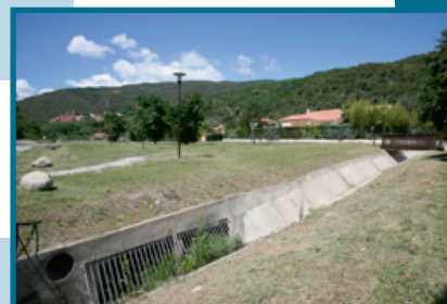
Evacuation des eaux dans le Tech, bassin de rétention, Can Malcion
