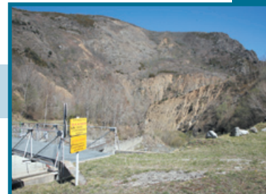
L'éboulement de La Baillanouse
